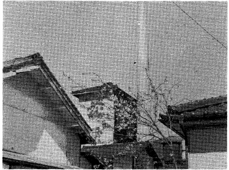
上田組合が設けた蒸溜塔（煙突の下の四角な塔）
